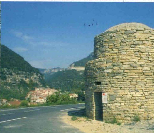
Réhabilitation d'une construction traditionnelle visible depuis l'autoroute
