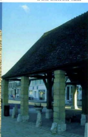
Réhabilitation d'une ancienne balle
